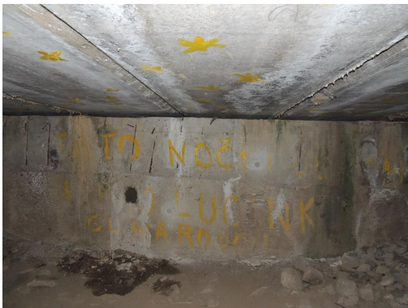
Pohled na levou opěru mostu se zapraveným místem po odběru vzorku betonu
