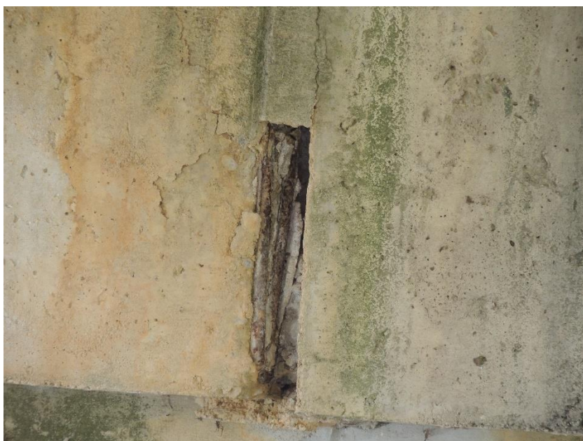
Obnažená korodující výztuž prefabrikátů v místě stykové spáry
