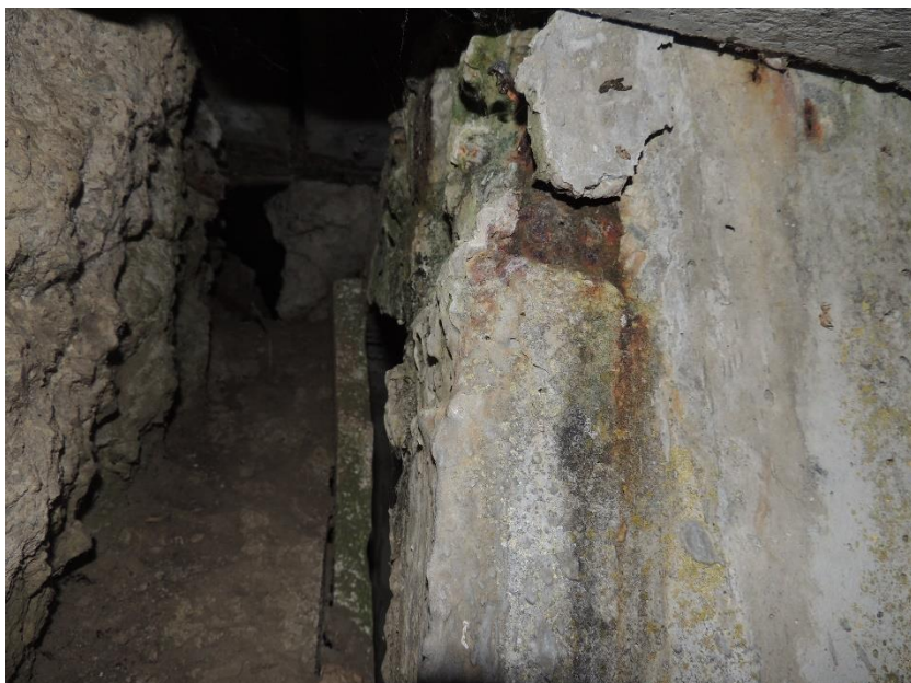
Obnažená korodující kotevní oblast horní předpínací výztuže krajního nosníku u pravé opěry
