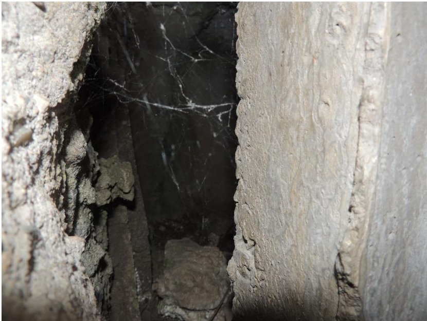
Pohled na mezeru mezi závěrnou zídkou a nosníky nosné konstrukce u levé opěry, možnost zatékání do dutin nosníků
