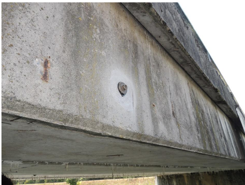
Pohled na zkušební místo pro stanovení soudržnosti povrchových vrstev a nedestruktivní stanovení pevnosti betonu nosníku
