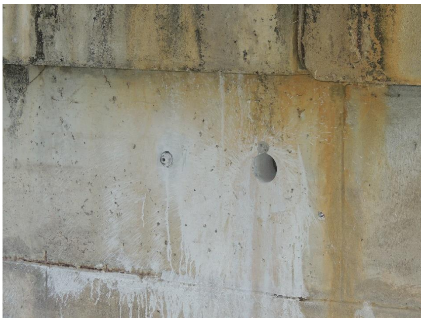
Místo odběru vzorku pro stanovení pevnosti betonu z levého pilíře
