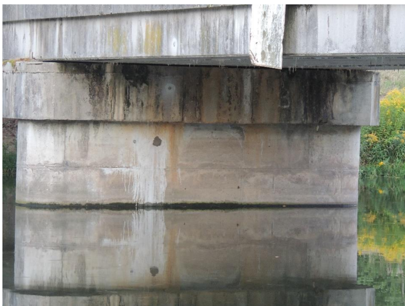
Pohled na levý pilíř po zapravení otvoru po odběru vzorku betonu
