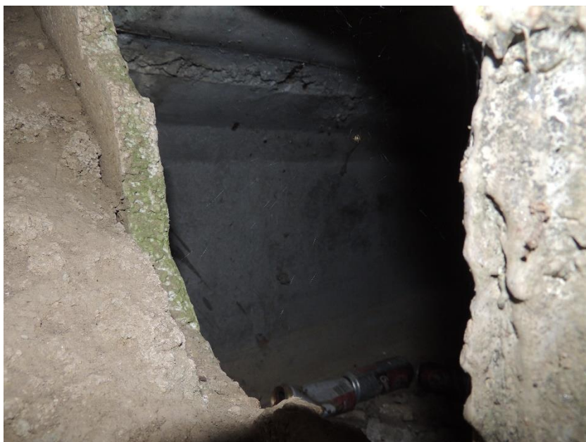
Pohled do dutiny krajního nosníku u levé opěry
