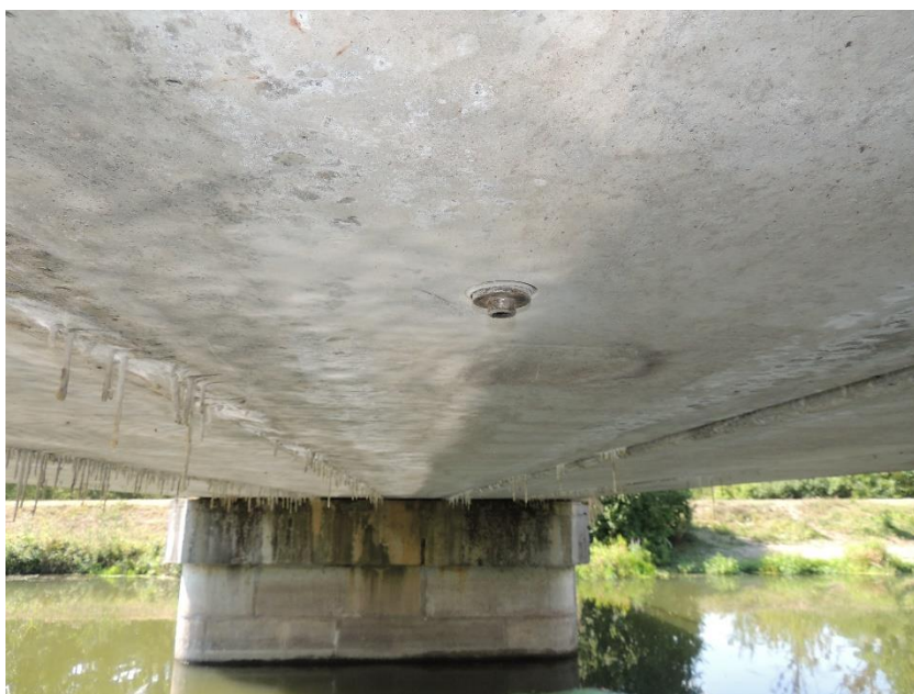
Pohled na zkušební místo pro stanovení soudržnosti povrchových vrstev a nedestruktivní stanovení pevnosti betonu nosníku
