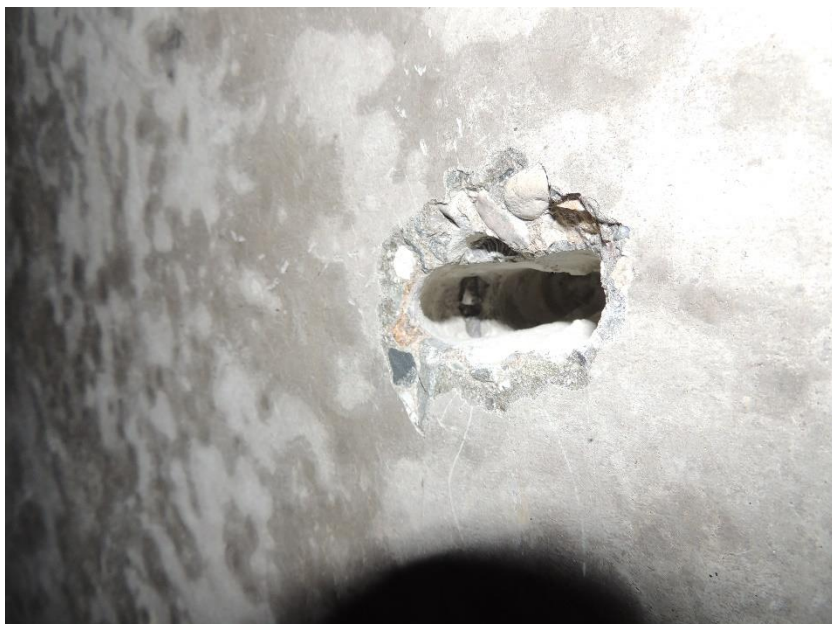
Sonda k předpínací výztuži nosníku pravého pole mostu
