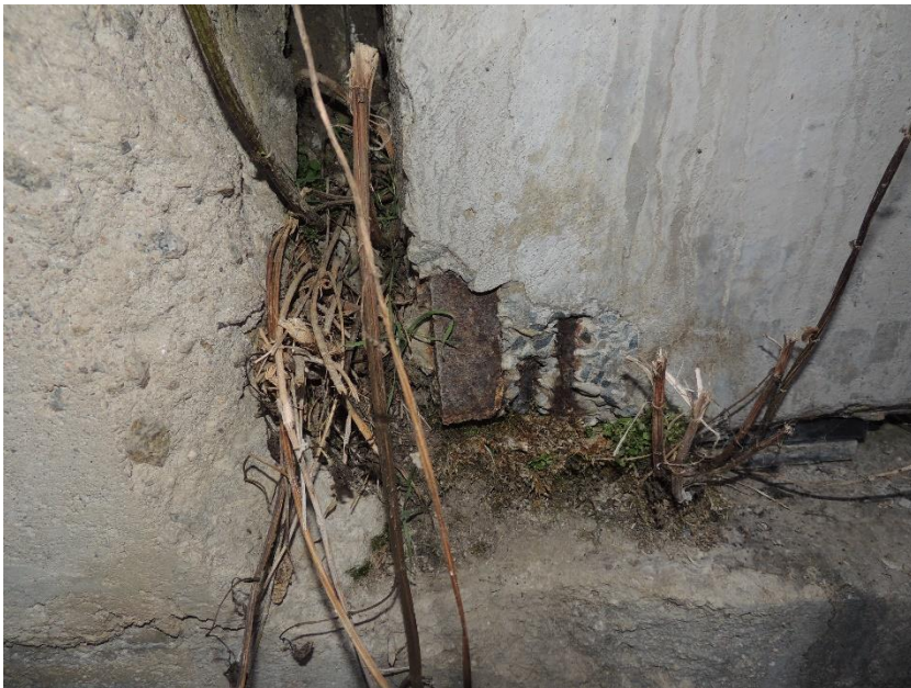
Obnažená korodující kotevní oblast předpínací výztuže krajního nosníku u levé opěry mostu
