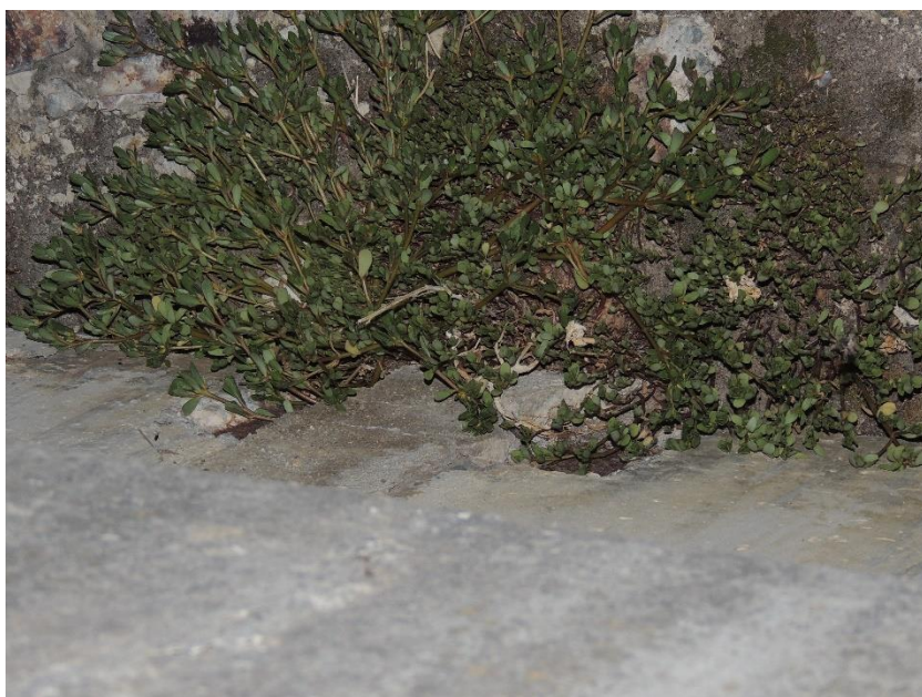
Uchycená vzrůstající vegetace na horním líci úložného prahu nad pilířem
