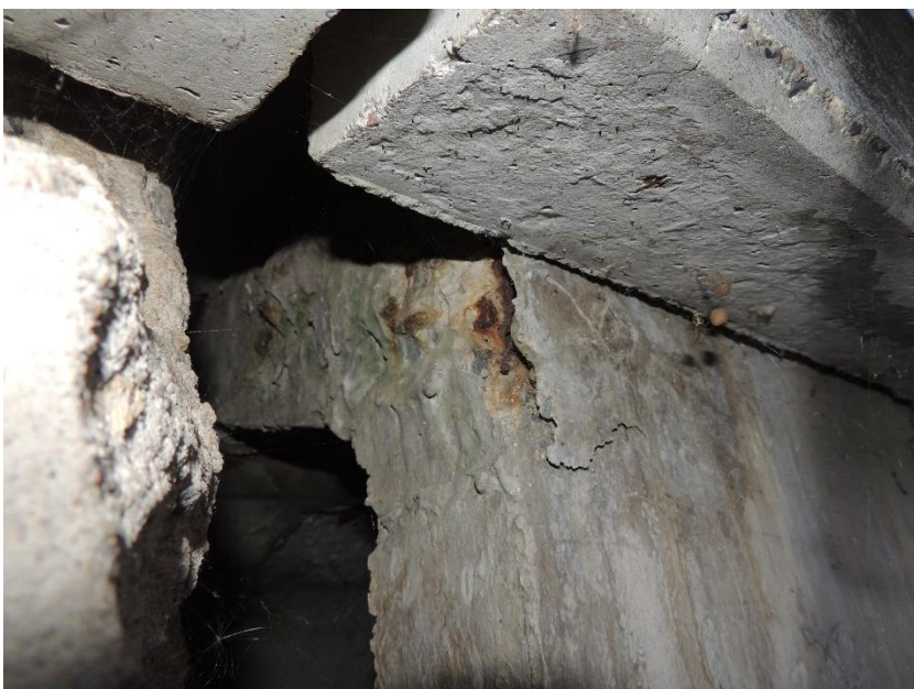
Pohled na horní líc dutiny krajního nosníku a kotevní oblast horní předpínací výztuže nosníku
