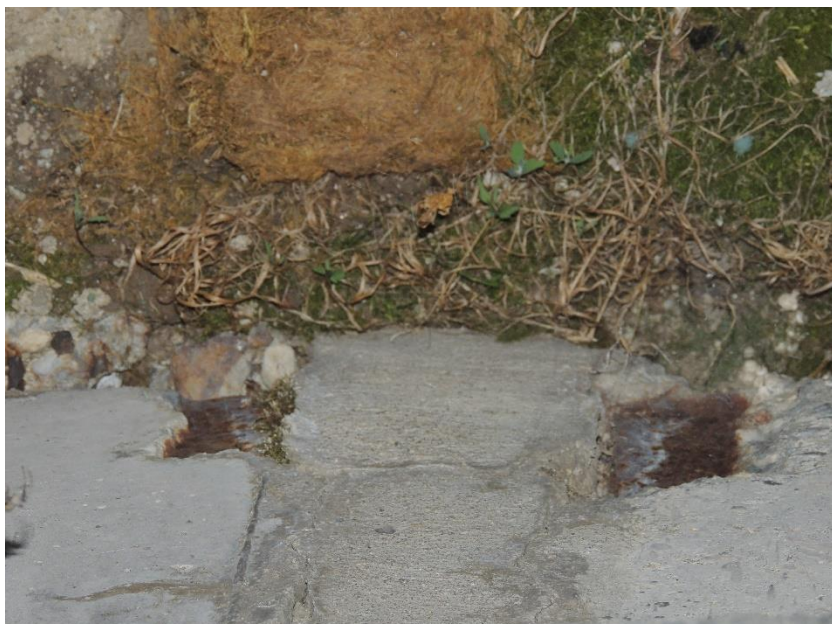
Obnažené kotevní oblasti dolní předpínací výztuže krajních nosníků nad pilířem
