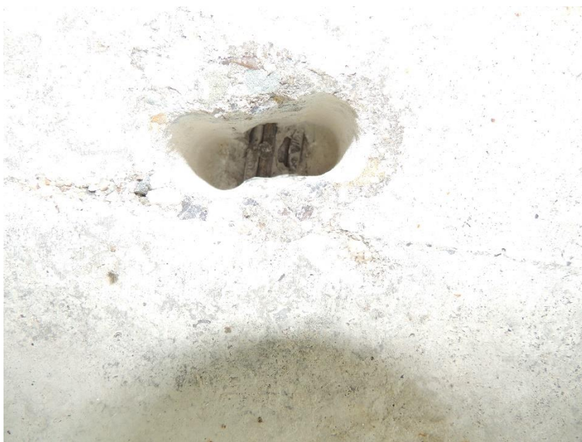
Sonda k předpínací výztuži nosníku středového pole mostu
