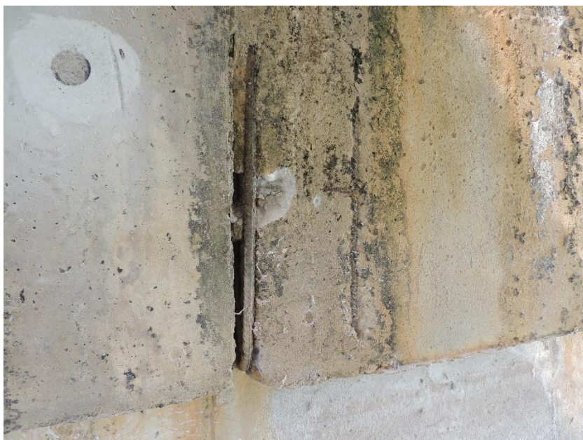
Pohled na zkušební místo po odtržení zkušebního terče a sondu k výztuži prefabrikátu úložného prahu levého pilíře
