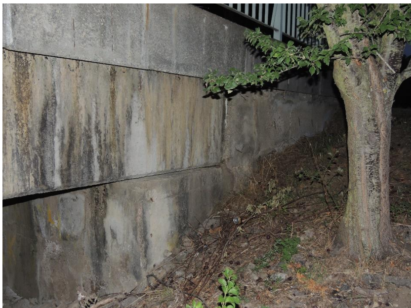
Pohled na uložení prefabrikovaných nosníků nosné konstrukce na levou opěru
