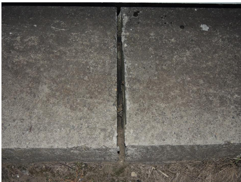
Styková spára prefabrikátů římsy
