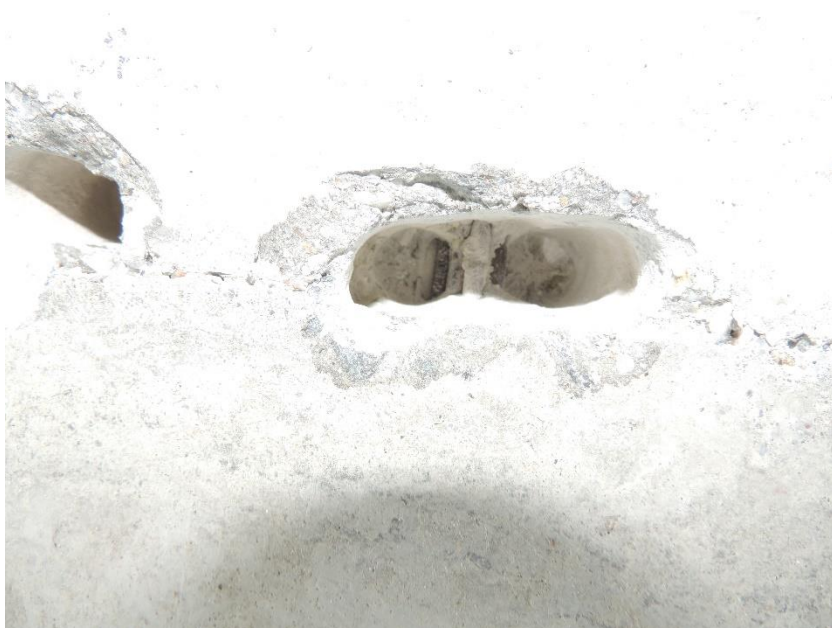
Sonda k předpínací výztuži nosníku středového pole mostu
