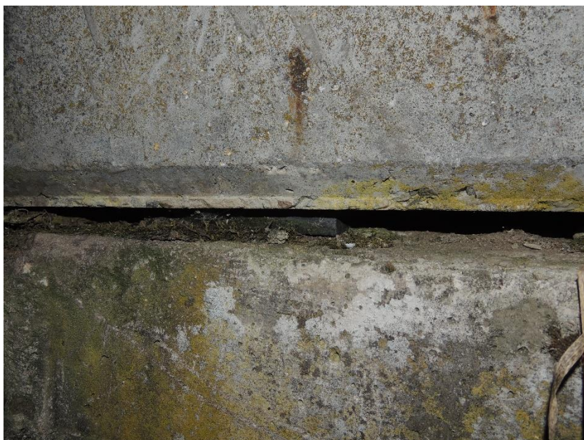
Pohled na elastomerové ložisko uložení nosníku nosné konstrukce na úložný práh opěry
