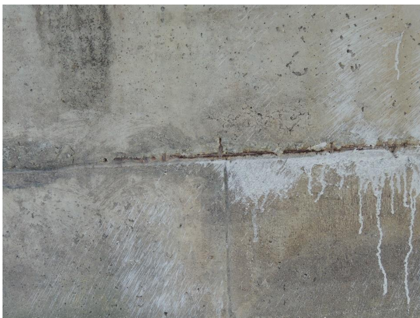
Obnažená korodující výztuž levého pilíře
